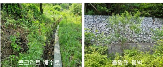
◆ 복원지에 잔존하는 돌망태(Gabion) 옹벽과 콘크리트 배수로는 그 일대에 서식하는 다양한 지표성곤충류의 이동에 장애요인으로 작용할 개연성이 큼. 대차방안으로 곤충용 생태통로 설치를 고려해 볼 수 있음.
